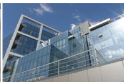
ルーバ窓の自動開閉
