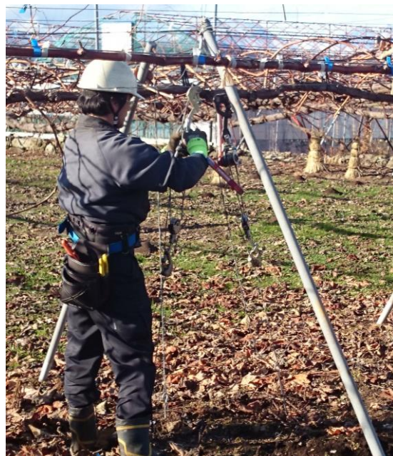
写真7 シメラーを用い、 幹線を張る
