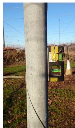
写真9 水平器でA マストの水平確認
